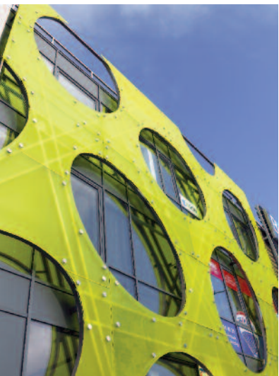
Detail předsazené stěny ze satinovaného plexiglasu.
